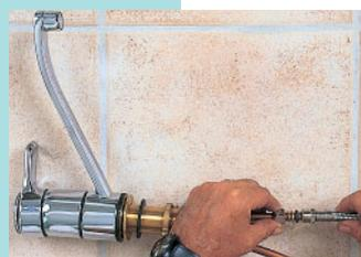
**4. Dans le cas d'un robinet équipé de tubes de cuivre, employer des flexibles à deux raccords rapides.**
