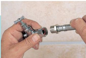
**1. Utiliser un flexible pour raccorder le robinet de chasse de la cuvette W.C.**
