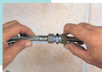
**5. Utiliser, par exemple, une réduction mâle/mâle pour assembler un flexible de lavabo à un tube de cuivre pourvu d'un collet battu**
